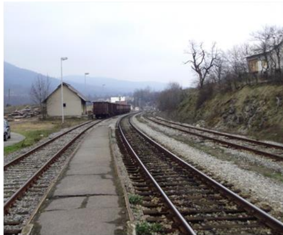
Prikaz 51: Primjeri sigurnosnih problema na kolodvorima u ruralnim područjima: Blata, Benkovac, Unešić i Đurmanec (nepostojanje nadzornih sustava, rasvjete, nesigurne pristupne staze)
